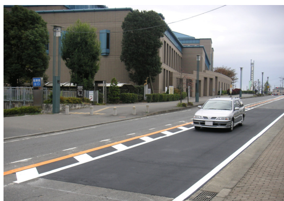
昨年11月25日、座間市役所前の市道に多機能型弾性舗装を片側車線の30メートル区間に施工。12月19日に騒音測定を行った
